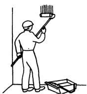
Маляр  $M_1$  погружает валик в ванночку с клеевым составом и, прокатив его по сетке для снятия изпишков, наносит состав на поверхность стены. Нанесенный состав выдерживают в течение 20 мин. Маляр  $M_2$  готовит клеевой состав и подносит его к рабочему месту
