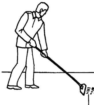
Облицовщик  $O_1$  стальным скребком очищает поверхность стяжки от грязи и наплывов раствора. Облицовщик  $O_2$  метлой выметает мусор из помещения
