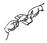
Расшивку трещин производят за два движения. Маляр М<sub>1</sub>, упираясь одной рукой в потолок, другой расшивает узким шпателем трещину в штукатурке на глубину около 2 мм. При этом плоскость шпателя должна быть наклонена вправо под углом примерно 60 к плоскости потолка. При пов-
