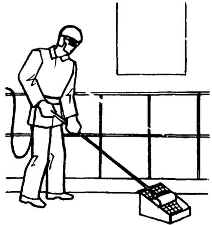
Оштукатуривочный состав на обрабатываемую поверхность фасада маляры наносят прокатывая валик вверх и вниз
