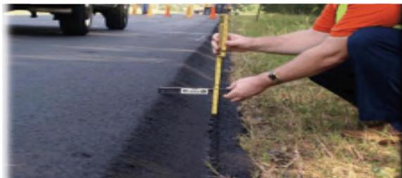
Рисунок 2 – Измерение толщины слоя по кромке
