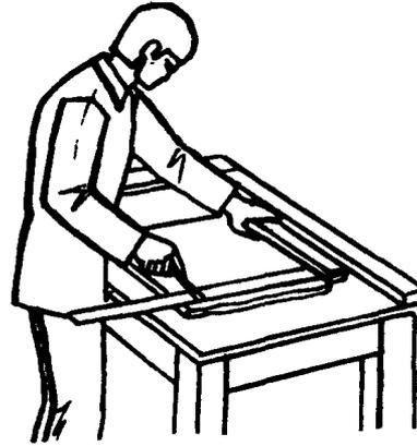
Облицовщики на верстаках проверяют геометрическую форму каждой плиты угольником. На неровных краях плит они стальной шпилькой проводят линии окола
