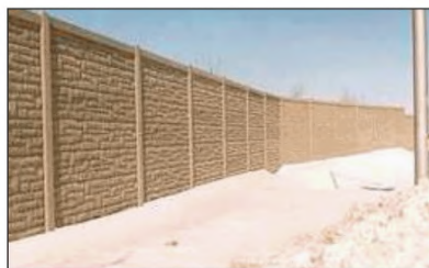
Рисунок 11.38 - Временное размещение снега у шумозащитного экрана в зимний период [12]
