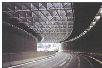
Рисунок 13.2 - Естественное освещение и проветривание шумозащитной галереи
