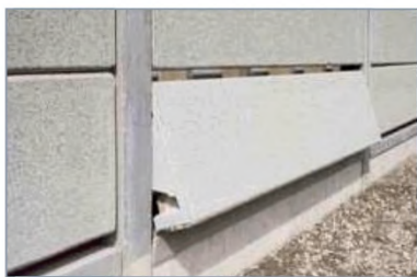
Рисунок 10.43 - Подвешенная нижняя панель экрана для отвода воды с проезжей части
