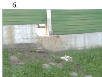
Рисунок 11.41 - Организация отвода воды с устройством паза (а) или отверстия (б) под шумозащитным экраном
