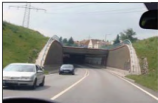
Рисунок 13.3 - Тоннели с полной изоляцией прилегающей территории от транспортного шума (а, б) и с использованием пространства над тоннелем для местного движения (в, г)
