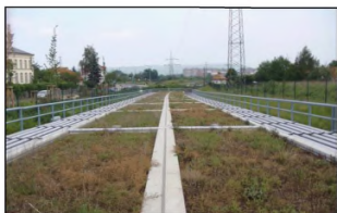
Рисунок 13.2 - Естественное освещение и проветривание шумозащитной галереи
