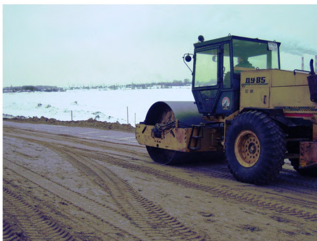
Р и с у н о к Г.5 – Устройство защитного слоя
