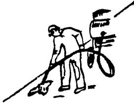
1. Прочистка трещин сжатым воздухом.
