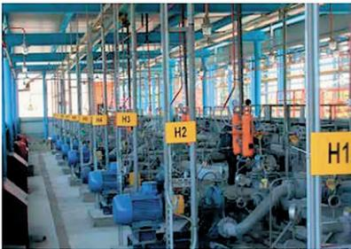
**Рис. 5.11.** Объект Росрезерва, оборудованный системой контроля загазованности и оповещения об аварийных утечках аммиака
