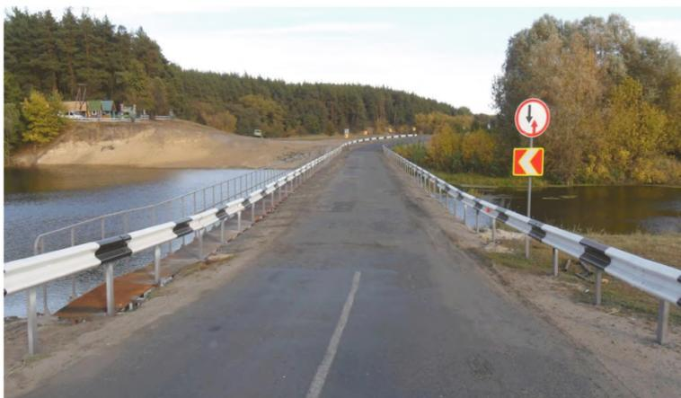
Рисунок 4 – Металлическое барьерное мостовое одностороннее дорожное ограждение
