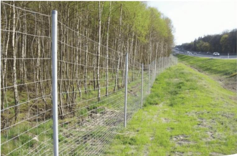
Рисунок 18 - Дорожное ограждение для животных, располагаемое по границе полосы отвода вдоль дороги
