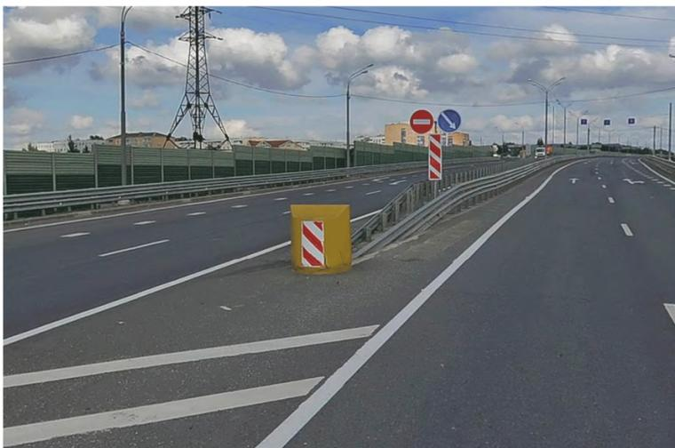
Рисунок 11 – Фронтальное дорожное ограждение в виде буфера на автомобильной дороге М-9 «Балтия»
