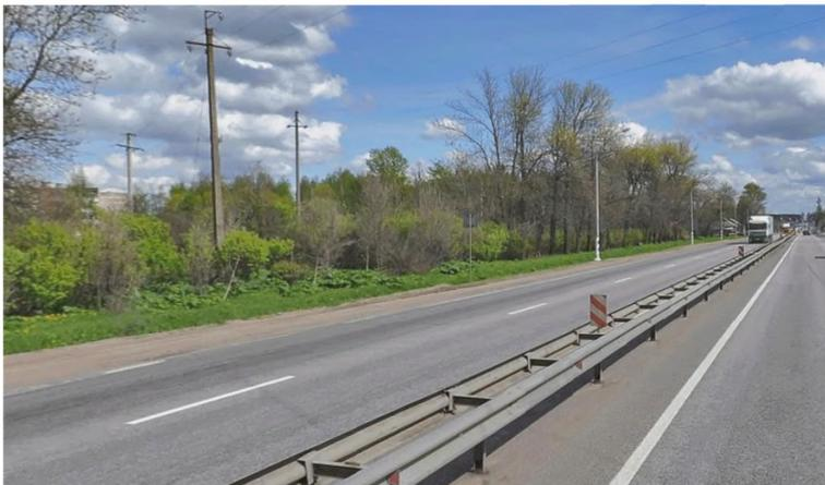
Рисунок 3 – Металлическое барьерное двустороннее дорожное ограждение на автомобильной дороге М-10 «Россия»
