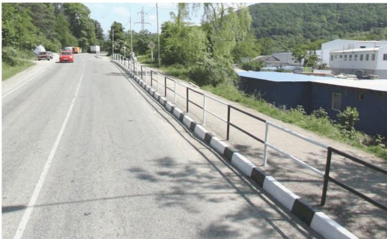
Рисунок 13 – Бордюрное дорожное ограждение вдоль тротуара
