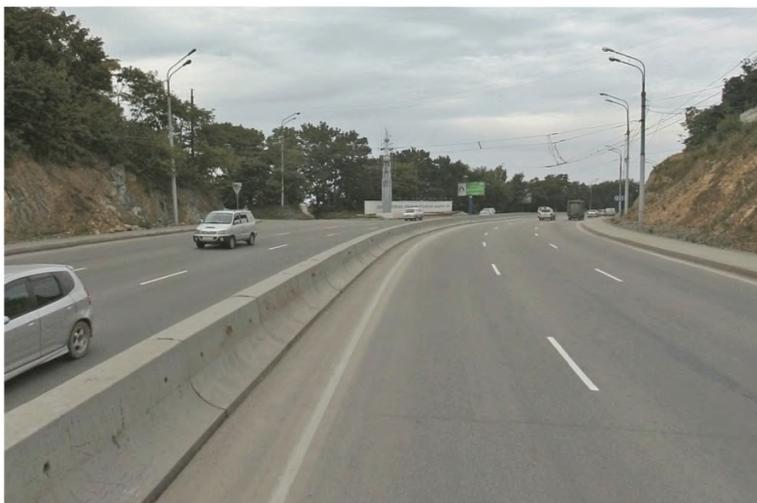
Рисунок 6 – Парапетное дорожное ограждение для разделения транспортных потоков
