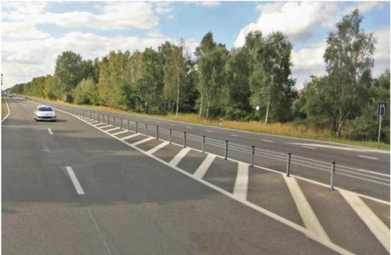
Рисунок 9 – Применение тросового дорожного ограждения на автомобильной дороге для разделения транспортного потока
