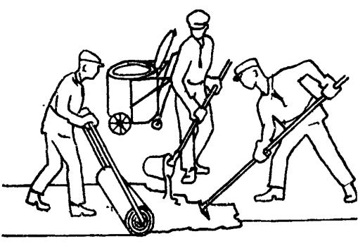
Кровельщик  $K_4$  набирает ковшом из бачка мастику и разливает ее по основанию. Кровельщик  $K_1$  разравнивает гребком разлитую мастику, а кровельщик  $K_2$ , раскатывая рулон, приклеивает полотнище
