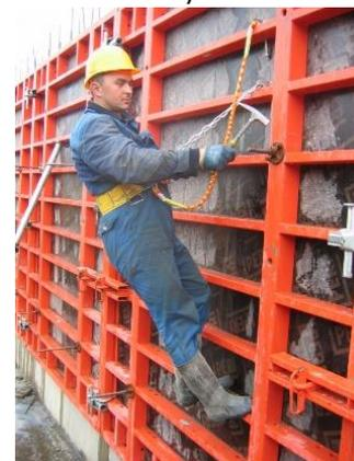
Применение: Для обеспечения возможности закрепления карабином и комфортного выполнения трудовых операций находясь непосредственно на металлических опалубках.
